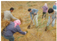
砂の移動を防ぐサンドソーセージと草方格作業
