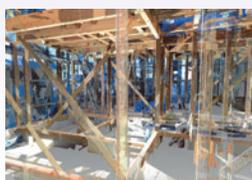
3Dレーザースキャナーで3Dモデル化した建築中の一軒家。
