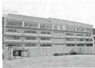
完成した新校舎
