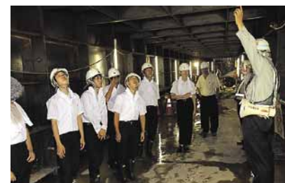
キャリア・スタディの一貫として、中学3年生が大成建設横浜支店を訪問。原宿交差点の立体化工事を見学しました
