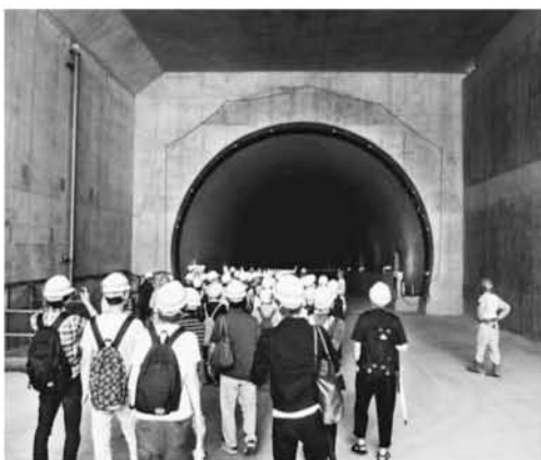
現場見学で訪れた東京港トンネル
