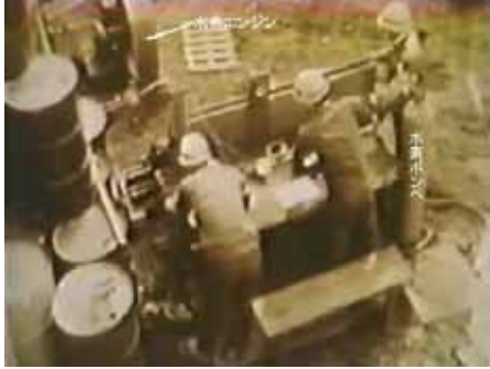
1970年日本で初めて水素燃料で駆動した水素エンジン運転風景 屋外で実験（NHKテレビ「あすへの記録」より）
